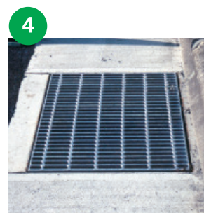
グレーチング設置
