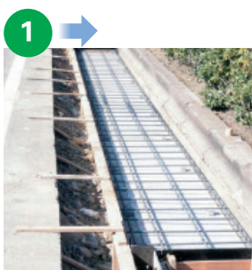
KCフォームの上に配筋した状態
