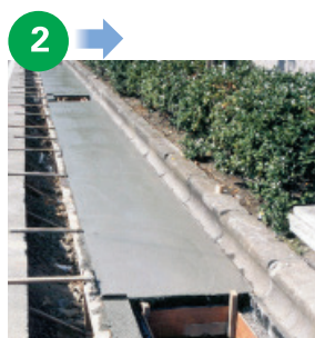
コンクリート打設
