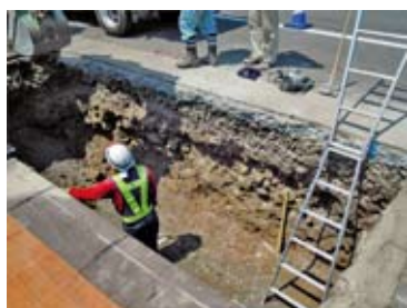
①掘削後敷砂
