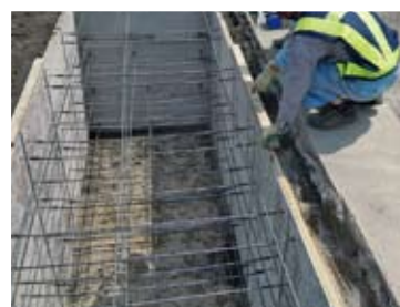
③型枠レベル調整
