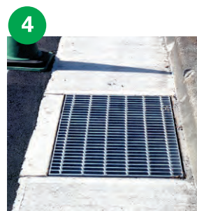
グレーチング設置
