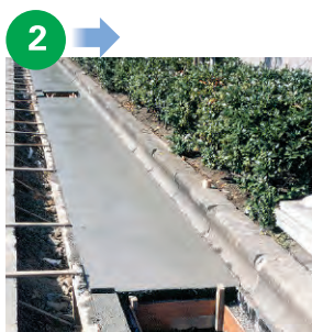
コンクリート打設
