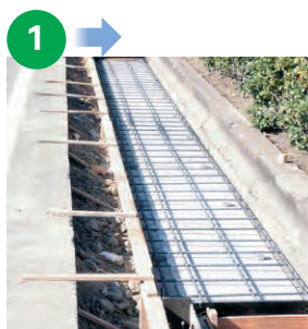
KCフォームの上に配筋した状態
