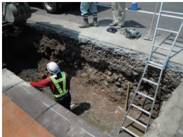
①掘削後敷砂
