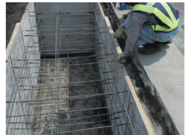
③型枠レベル調整
