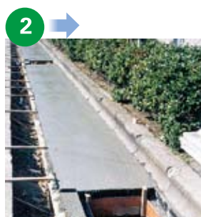
コンクリート打設
