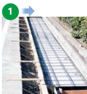
KCフォームの上に配筋した状態
