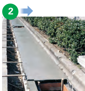
コンクリート打設
