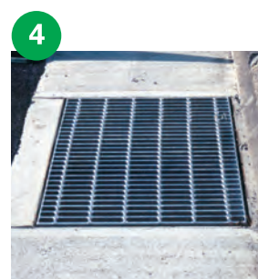
グレーチング設置
