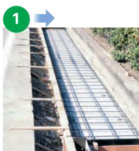
KCフォームの上に配筋した状態
