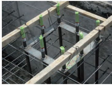
④アンカー筋設置
