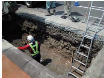
①掘削状況
