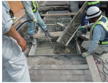
⑤生コン打設
