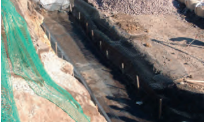
1.かごテンサー基礎敷設
