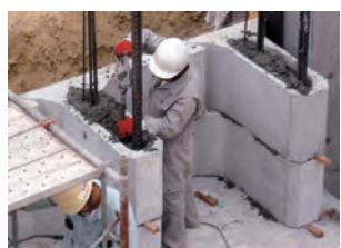
⑤ 縦貫コンクリート打設
