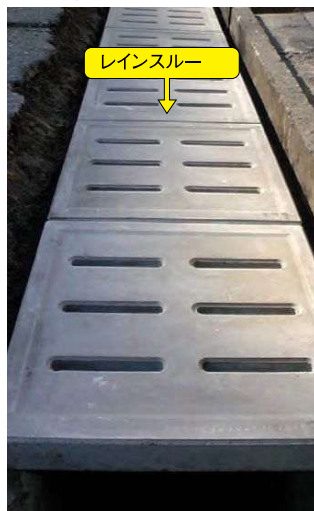
▼施工中(レインスルー敷設)
