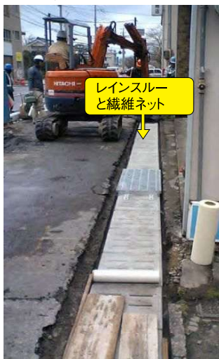
▼施工中(繊維ネット敷設)
