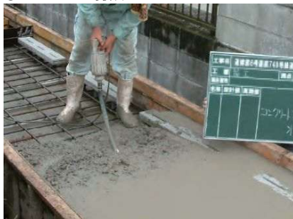
④コンクリート打設
