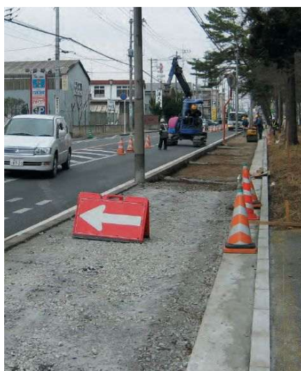
▲KCフォーム施工
