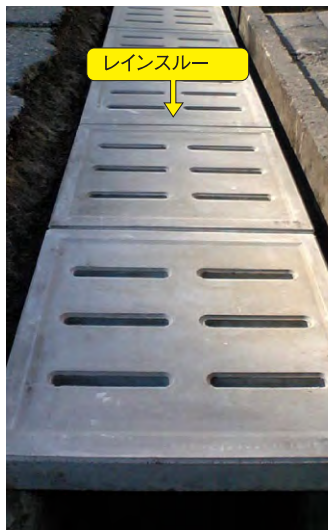
▼施工中(レインスルー敷設)
