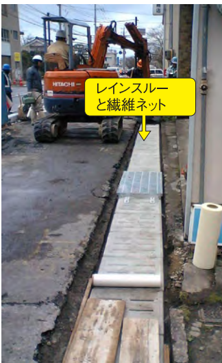
▼施工中(繊維ネット敷設)
